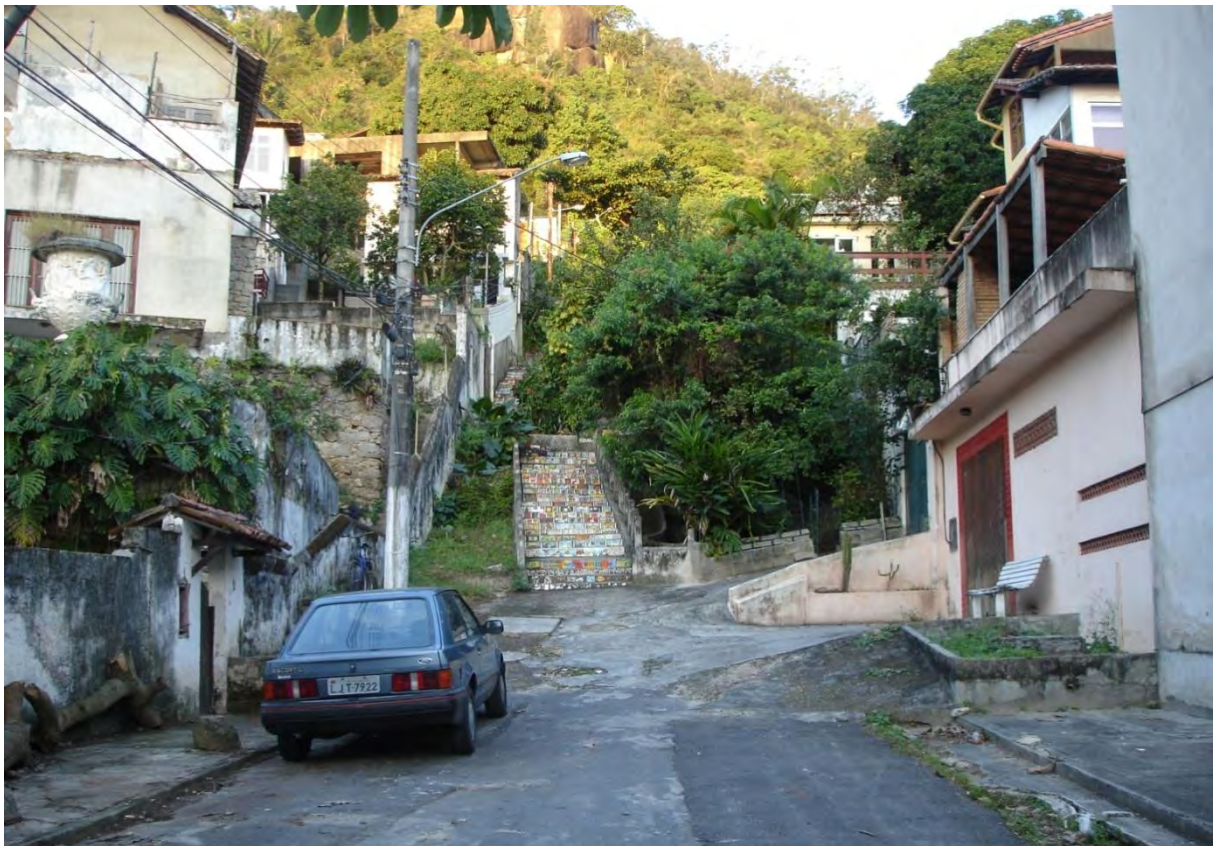
Fig. 18 - Início da Rua Oscar Pereira e a escadaria de mosaico ao fundo
