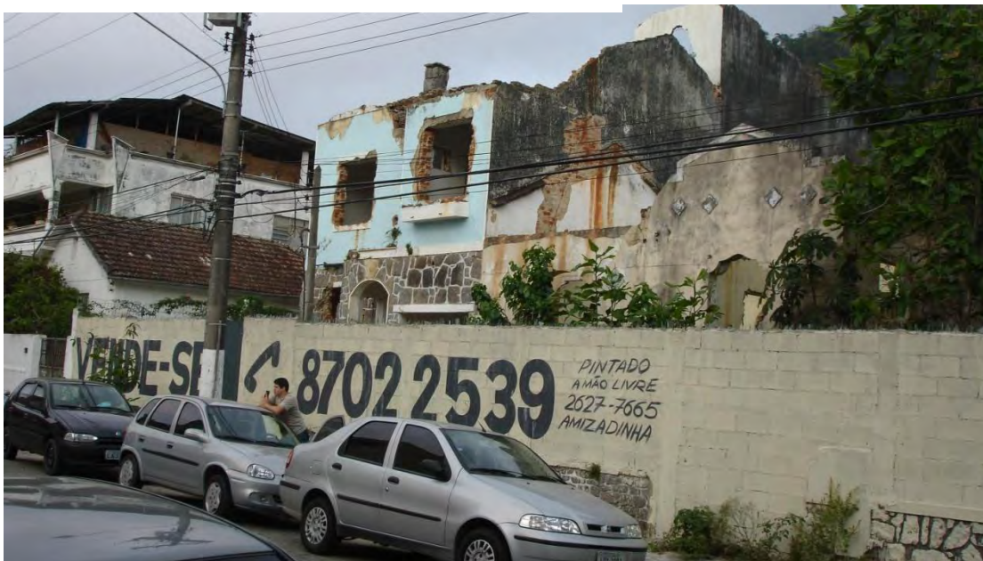
Fig. 14 - Várias casas do bairro sendo demolidas para dar lugar aos novos edifícios
