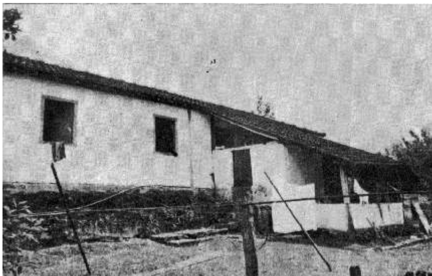
Fazenda de Dona Maria, situada à beira da estrada da Fazenda das Pedras Negras; construção elementar de início do século com estrutura de madeira e fechamento de pau-a-pique.
