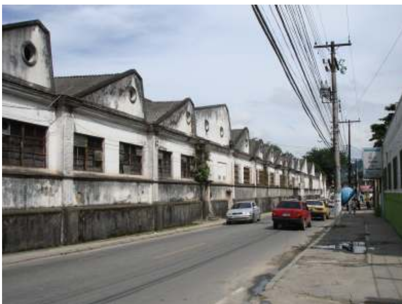
Fabrica Santo Aleixo - telhado em "sheds"
