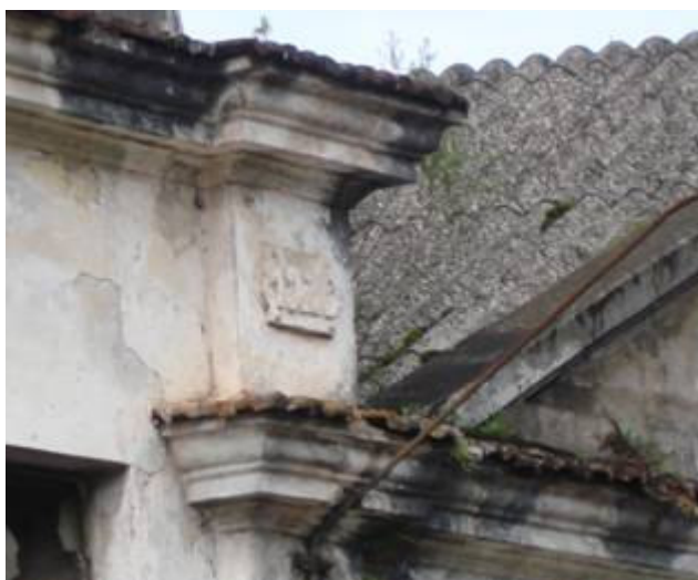
Figura 16 – Detalhe de uma das colunas com a data da sua construção Fonte: Foto da autora
