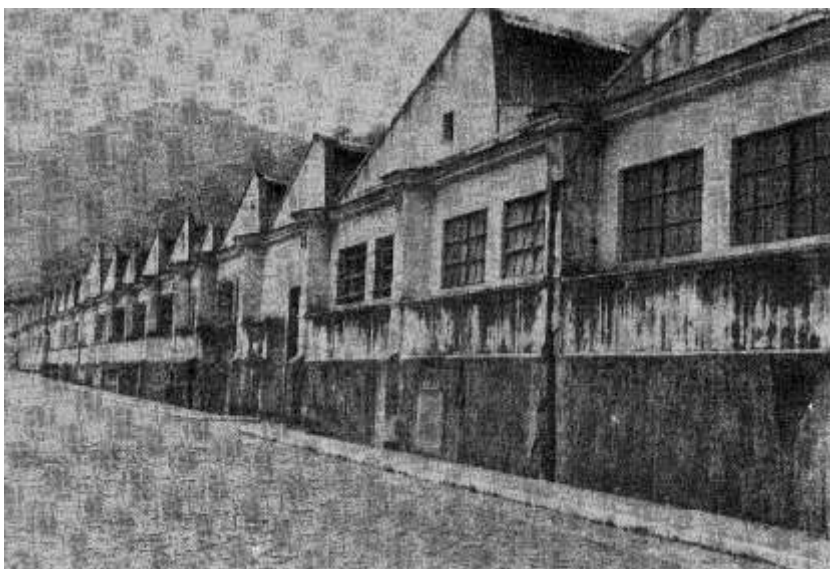
Fábrica Esther, construção de 1948 com cobertura em "sheds" na mesma direção ao longo da estrada; persistência de elementos decorativos de gosto clássico, como cimalkas e cunhais.
